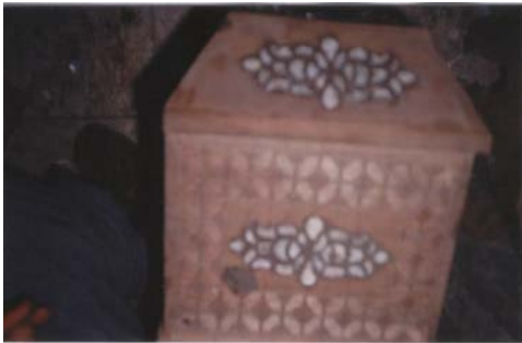
Şekil 3.18. Sedeflerin harç ile yuvalarına yerleştirme işlemi
